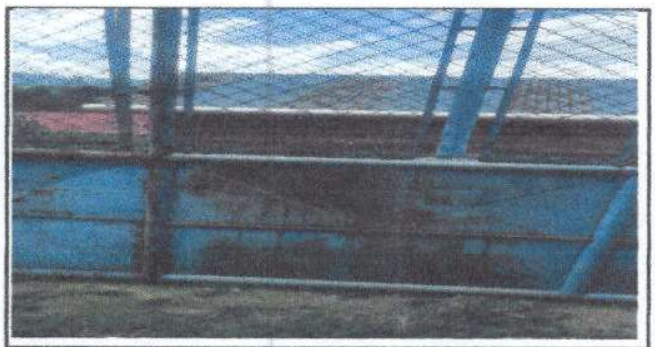
Foto 6: Mantenimiento a portones de metal
