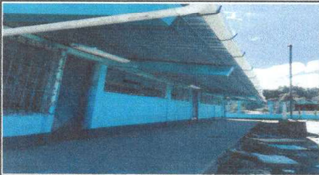
Foto 3: Sustitución de vidrios
