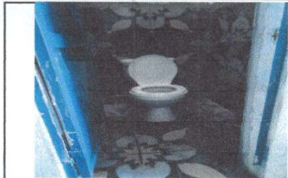
Foto 2: Sustitución de inodoro
