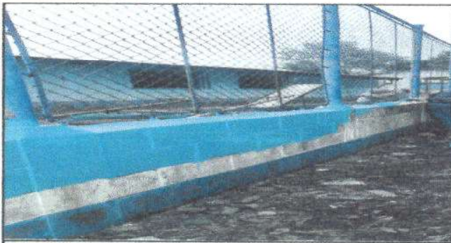
Foto 5: Reparación de tubo hg y malla galvanizada
