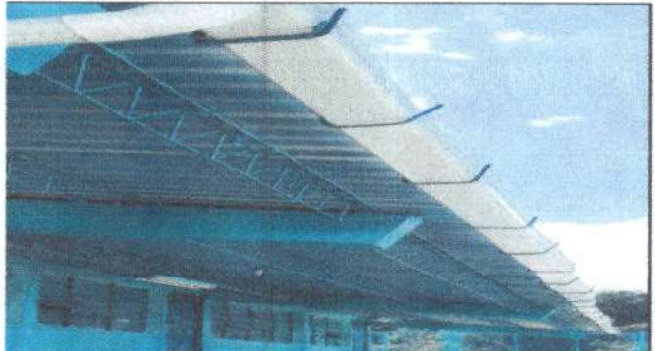
Foto 4: Mantenimiento a estructura de soporte metal
